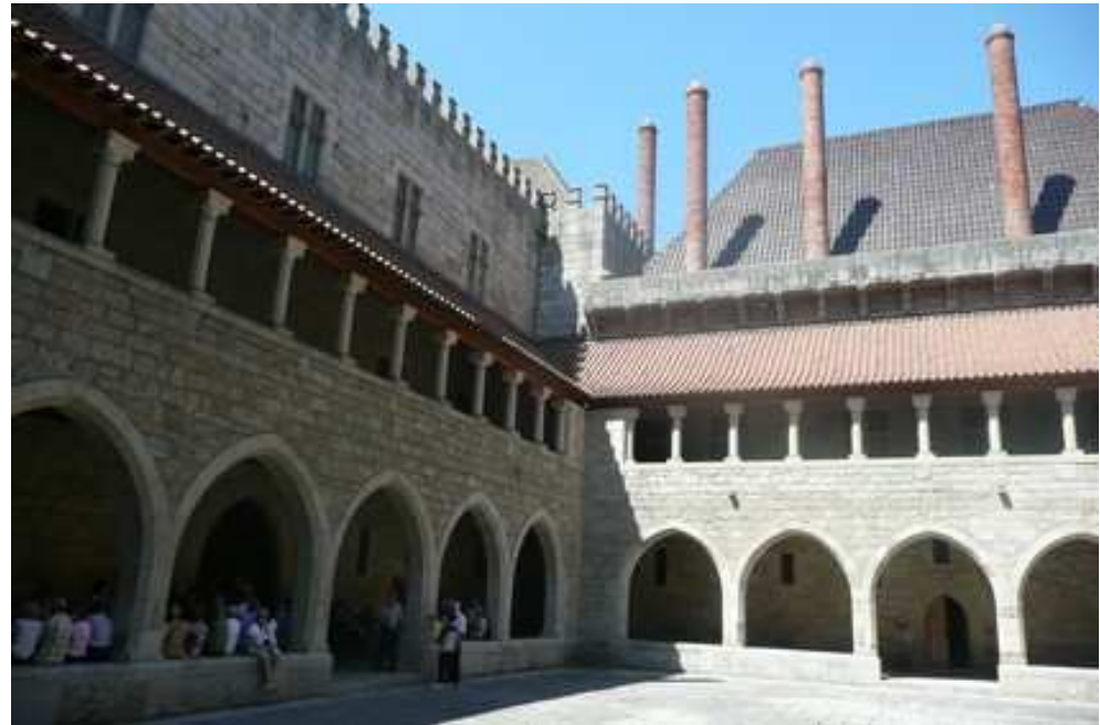
Château Palis des Ducs (4 de ses 39 cheminées)
