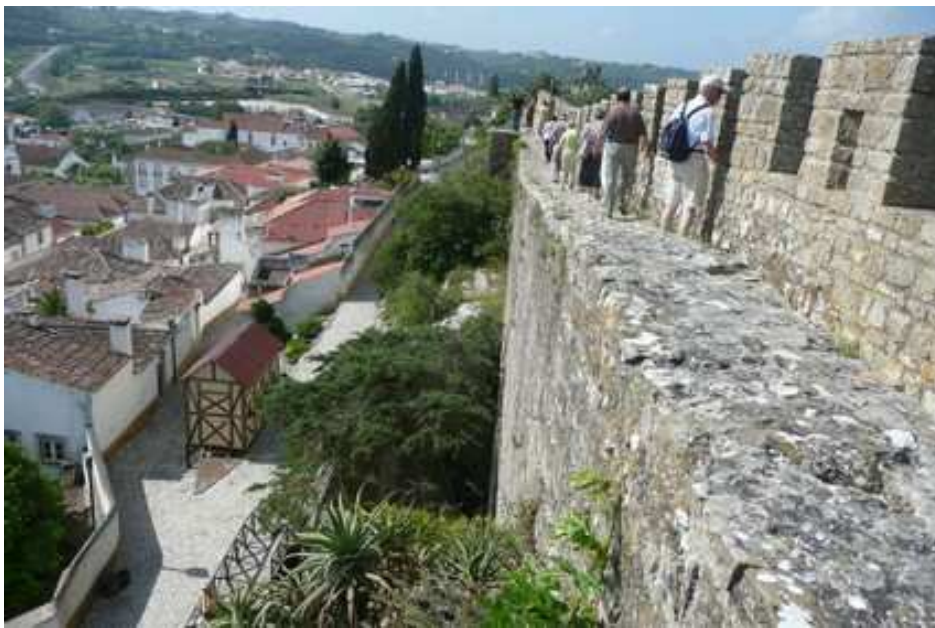
Sur les remparts (ou quand on ne respecte pas les normes de sécurité)
