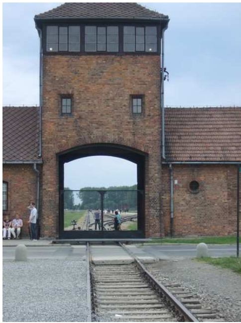
Porte de la Mort rails raccordés au réseau ferroviaire
