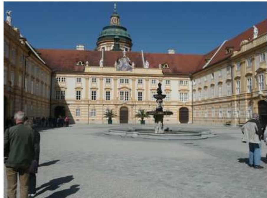
Façade ouest – La Prudence
