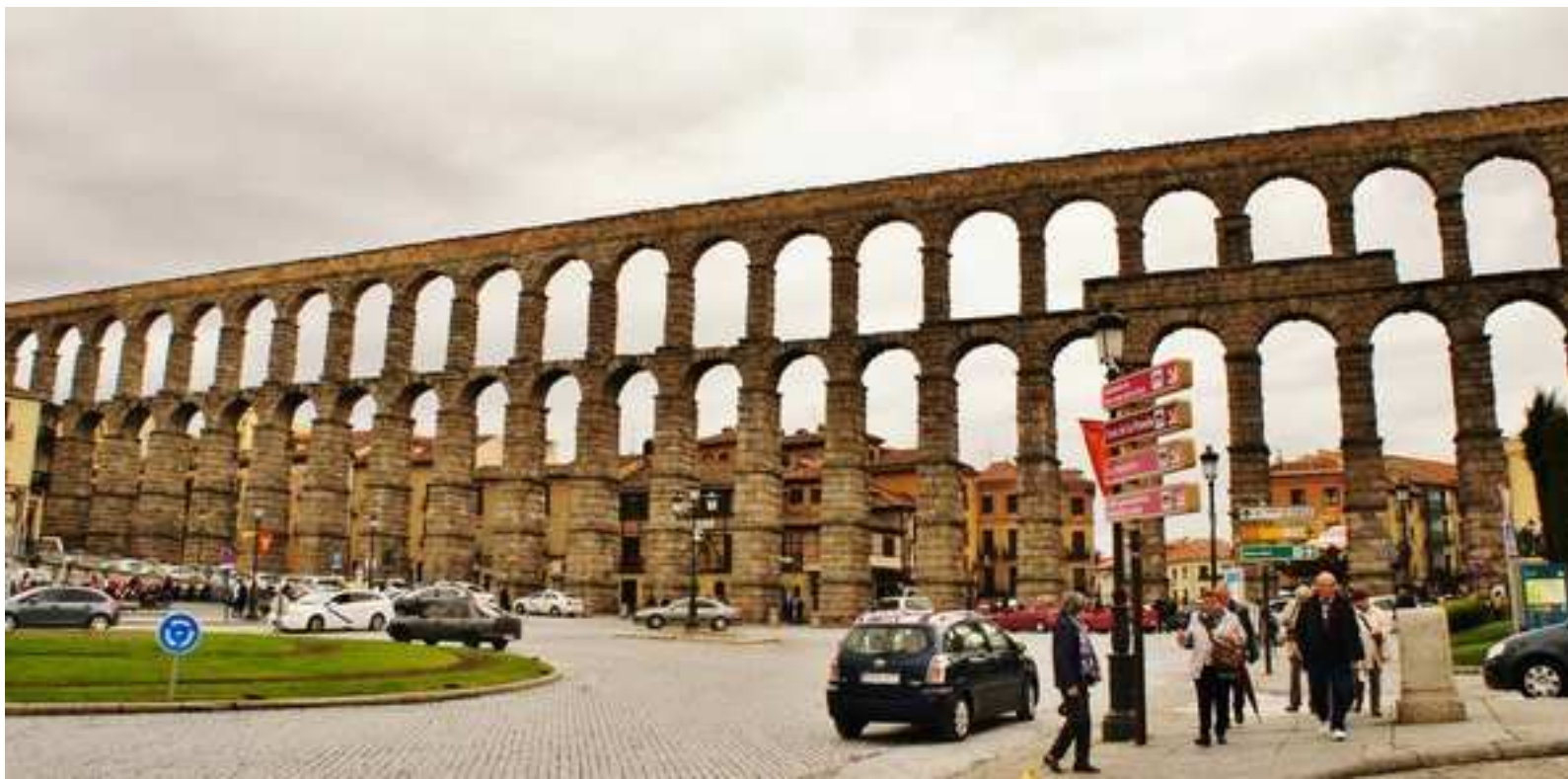
sans oublier l'aqueduc avant de repartir
