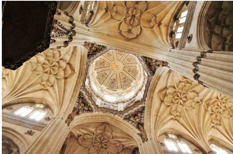
avec ses voûtes impressionnantes
